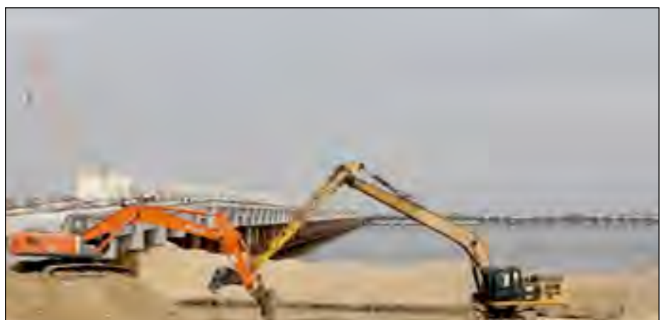
Première Phase, Le terminal de Gaz naturel liquéfié
